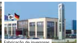
Fabricação de inversores
