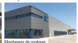
Montagem de motores
