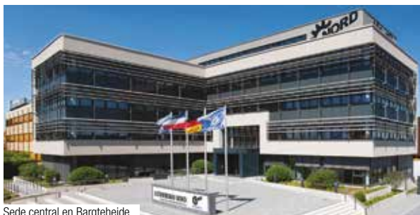
Sede central en Bargteheide
