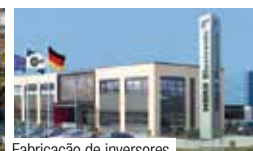
Fabricação de inversores
