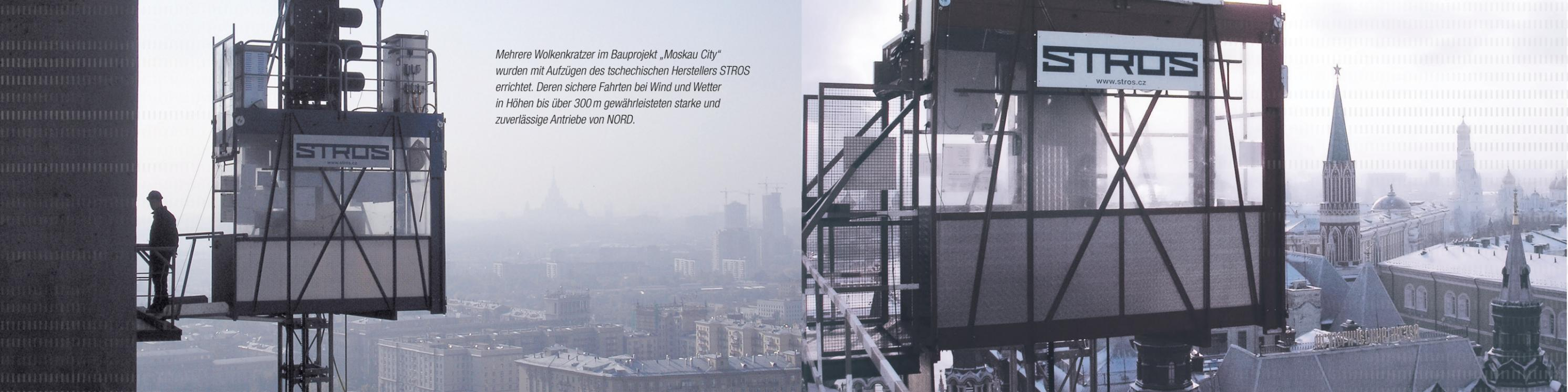
Mehrere Wolkenkratzer im Bauprojekt „Moskau City“ wurden mit Aufzügen des tschechischen Herstellers STROS errichtet. Deren sichere Fahrten bei Wind und Wetter in Höhen bis über 300 m gewährleisten starke und zuverlässige Antriebe von NORD.
