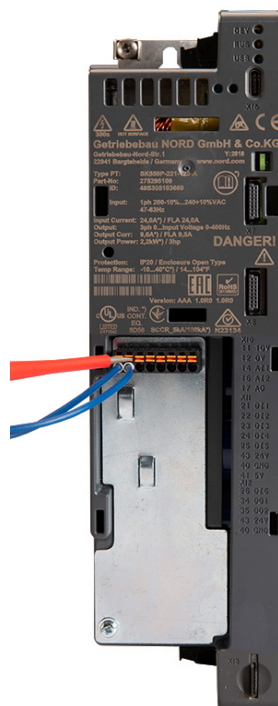
Fissaggio delle connessioni (terza mano)
