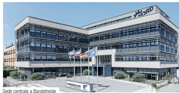
Sede centrale a Bargteheide
